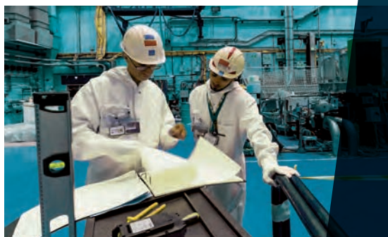
Installation Phébus en démantèlement à Cadarache. ©P. Dumas/CEA
