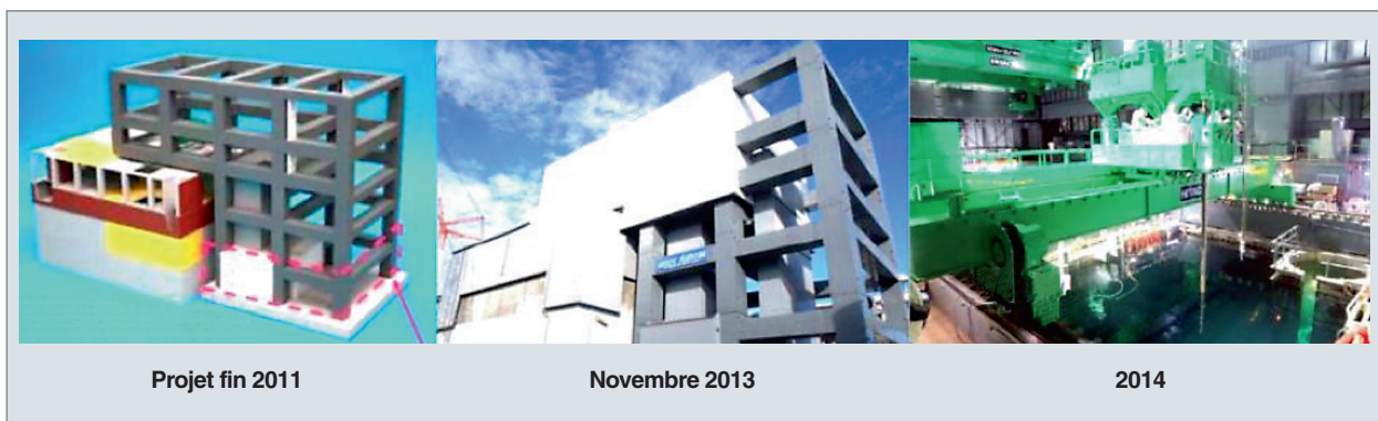
Fig. 206. Construction d'un hall de manutention en surplomb de la piscine d'entreposage des combustibles usés du réacteur n°4 de Fukushima.
