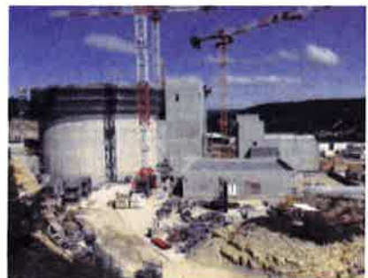
Vue du chantier RJH
