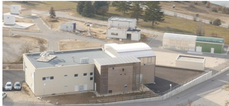
Vue de la zone de la grande bastide de la Cité des énergies A droite : la serre de culture des microalgues
