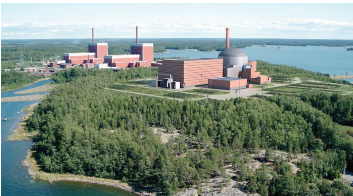
Le site d'Olkiluoto (Finlande) avec au premier plan, en image de synthèse, le premier réacteur nucléaire européen de troisième génération (EPR), qui sera construit par Framatome-ANP (groupe Areva) et Siemens (pour l'îlot conventionnel), précédant la tête de série qu'EDF a décidé de construire à Flamanville (Manche). Au second plan figurent les deux réacteurs de deuxième génération actuellement exploités par TVO.
