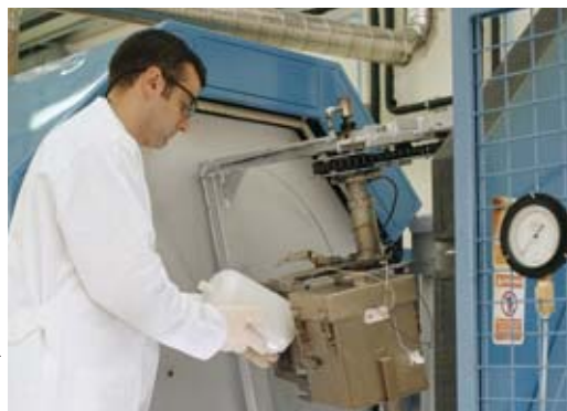
Installation de rotomoulage, au centre CEA du Ripault (Indre-et-Loire), des vessies plastique de réservoirs pour le stockage de l'hydrogène. Le moule tourne en 3 dimensions dans un four à 350 °C.
