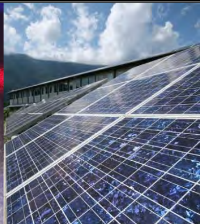
Panneaux solaires – Crédit : C. Dupont/CEA
