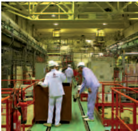
De g. à dr. : démantèlement d'une salle dans l'usine UP1 – la balise Dirad est un système de détection gamma automatisé, développé par le CEA dans le cadre de ses recherches NRBC.
