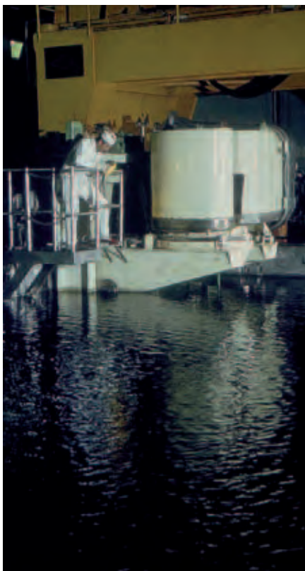
Piscine d'entreposage de combustible Pegase.
