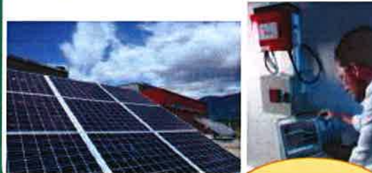
Plate-forme "systèmes électriques"
