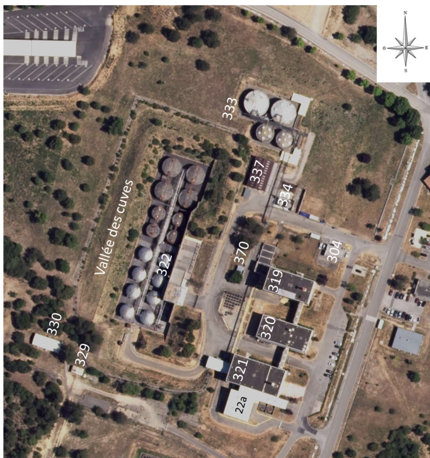
Figure 4 : Vue aérienne de l'INB 37B et identification des bâtiments implantés sur le périmètre de l'INB 37B présenté dans le dossier de démantèlement (ou périmètre modifié)
