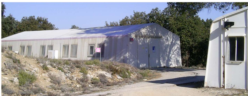
Figure 15 : Vue des bâtiments 330 (gauche) et 329 (droite)
