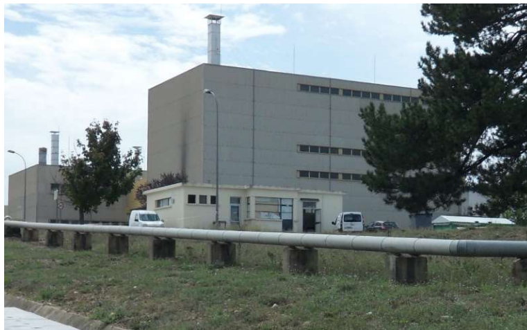
Figure 13 : Vue du bâtiment 304 (au premier plan de la photographie)
