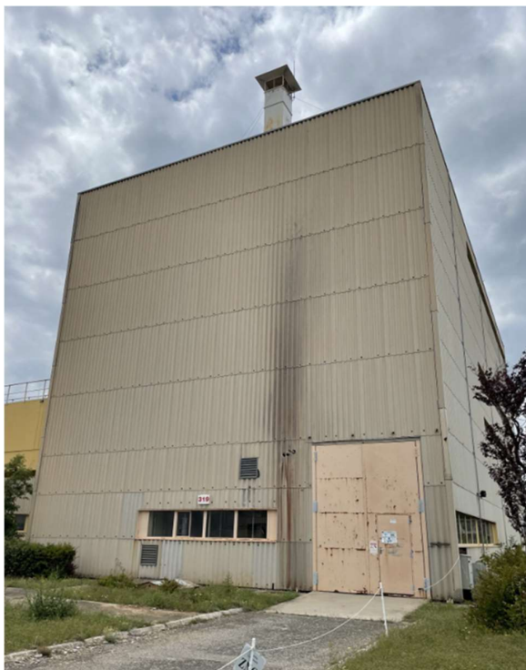
Figure 6 : Vue de la façade ouest du bâtiment 319
