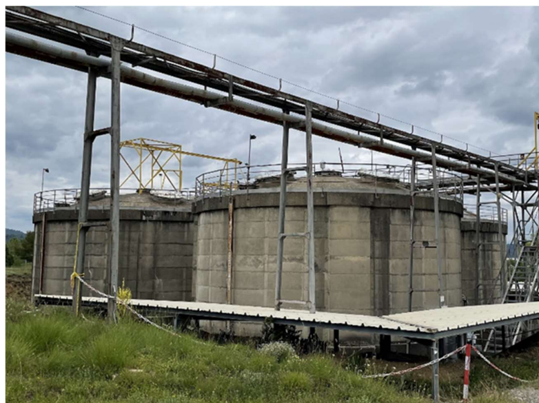
Figure 10 : Vue du bâtiment 333
