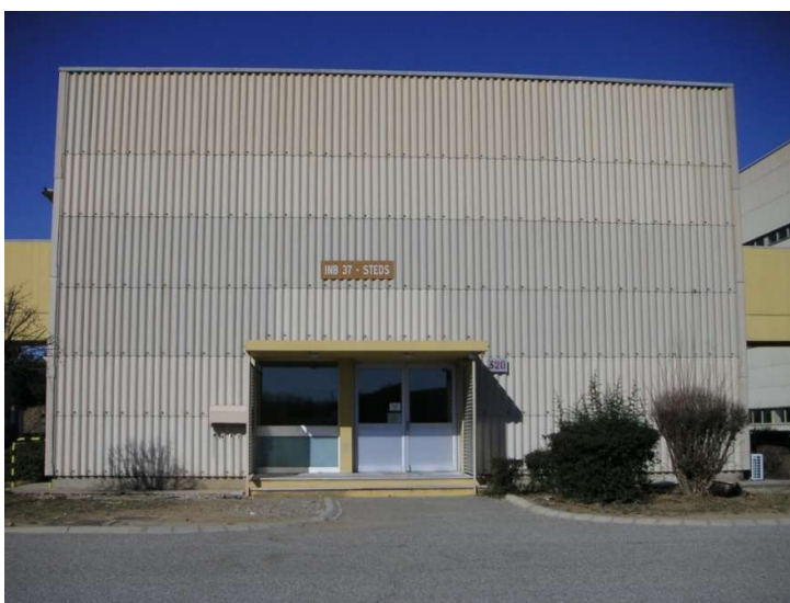
Figure 7 : Vue de la façade Est du bâtiment 320
