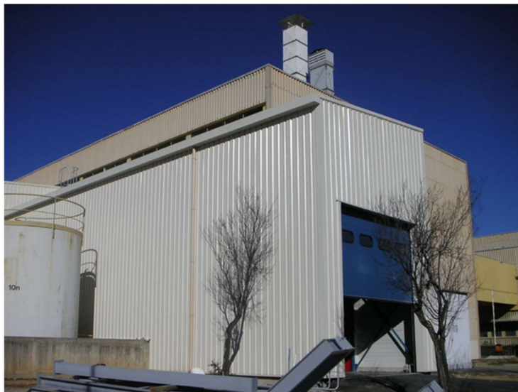
Figure 8 : Vue des façades Sud (partielle) et Est du bâtiment 321
