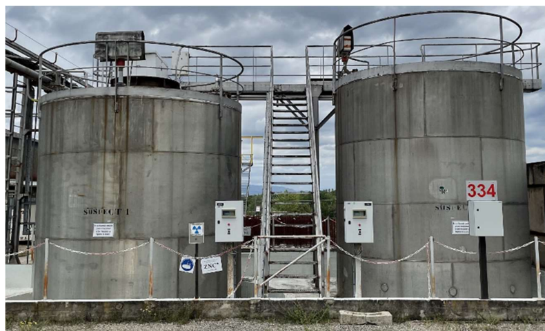
Figure 11 : Vue du bâtiment 334
