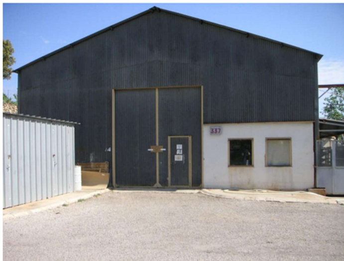
Figure 12 : Vue de la façade Sud du bâtiment 337
