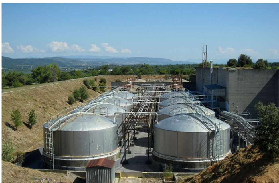
Figure 9 : Vue du bâtiment 322 – « vallée des cuves »
