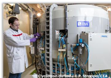
Un cyclotron biomédical est un accélérateur de particules qui produit des isotopes radioactifs en bombardant des éléments stables avec des protons.
