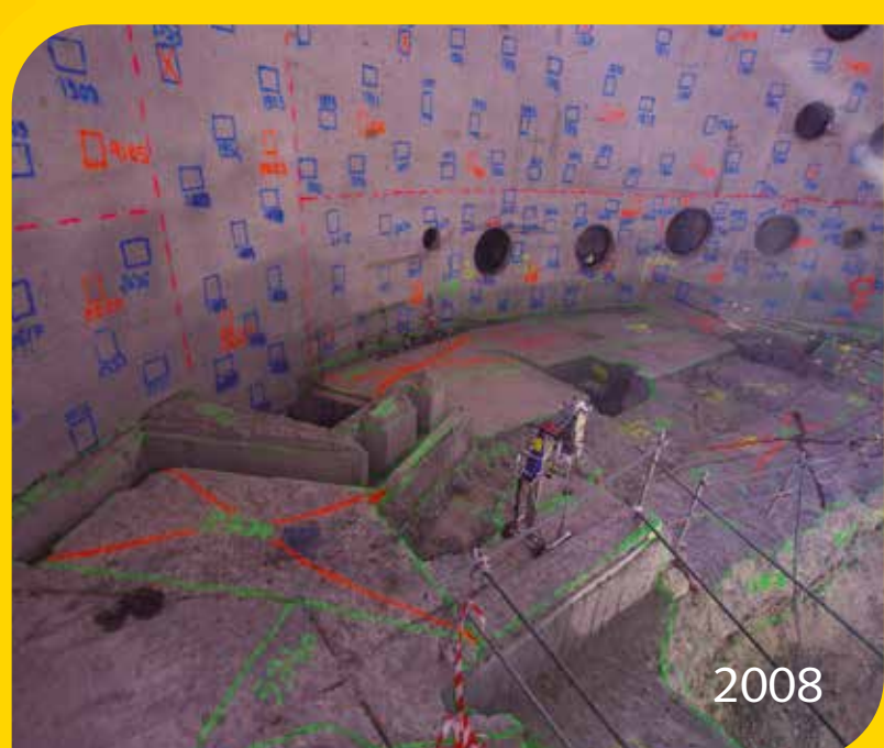
Fin des travaux de démantèlement dans le réacteur Siloé.
