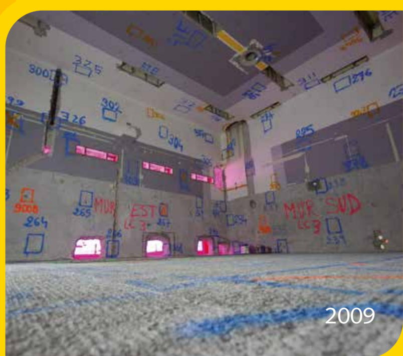
Fin des travaux de démantèlement au LAMA (laboratoire d'analyse de matériaux actifs).
