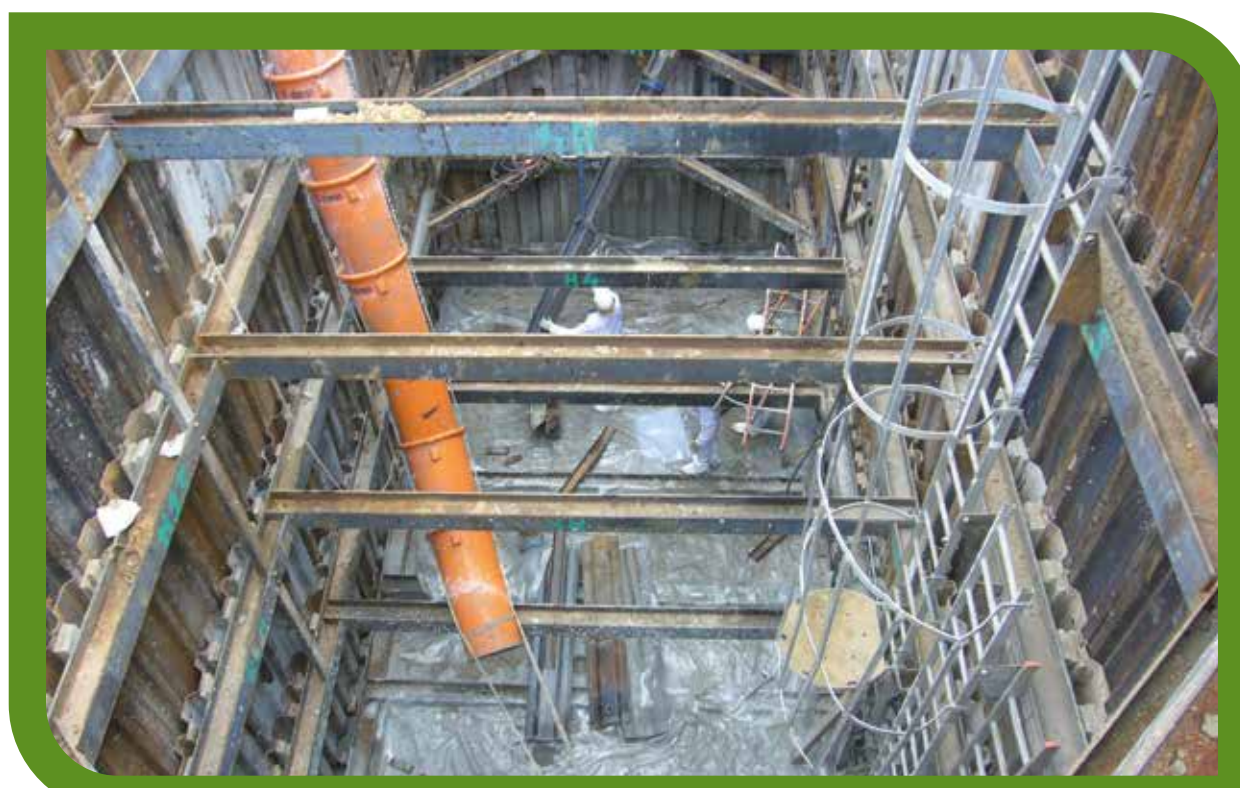
Atteinte de l'objectif radiologique : préparation du remblaiement avec du remblai liquide, contrôle des matériaux de blindage à la remontée.
