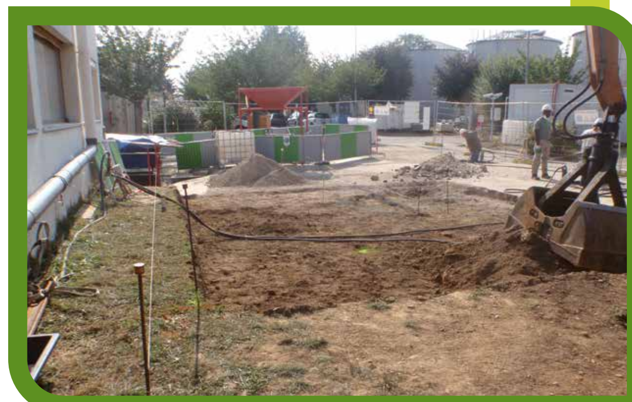
Remblaiement des 2 derniers mètres en grave naturelle compactée par couche de 30 cm.
