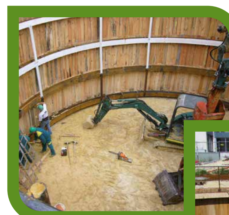
Opérations de préparation de la fosse.
