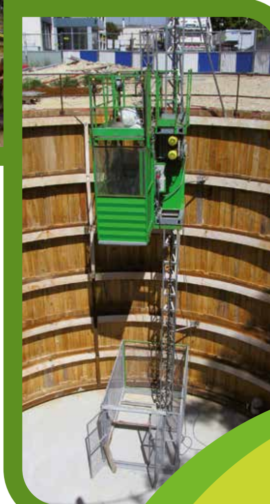
Fin des opérations de préparation de la fosse accédant aux cuves d'entreposage.
