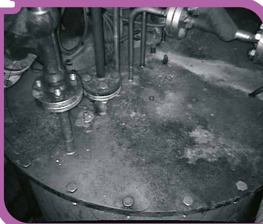
Inspection vidéo de la salle des cuves.
