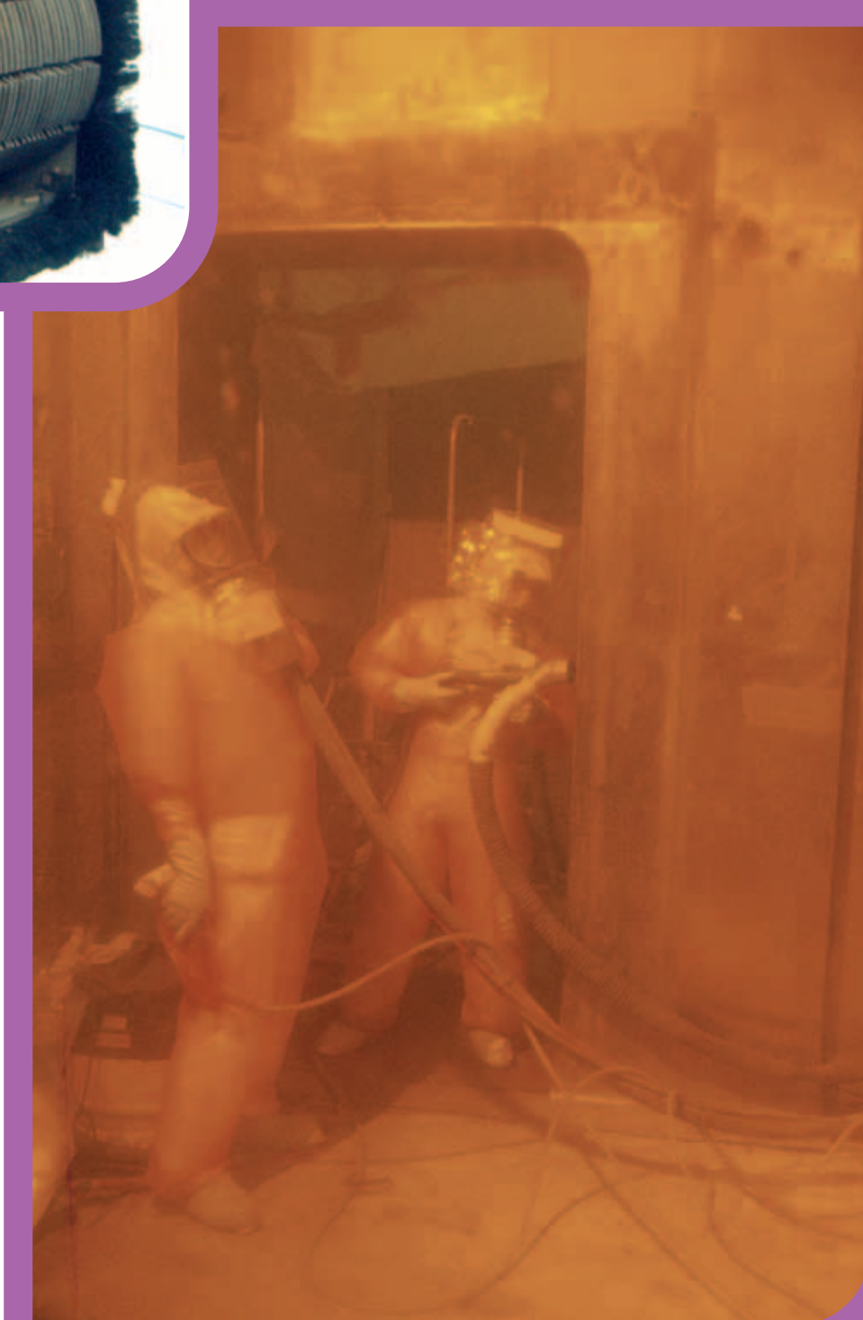
La raboteuse et la technique du sablage sont utilisées afin d'enlever de fines couches de béton ou de métal.
