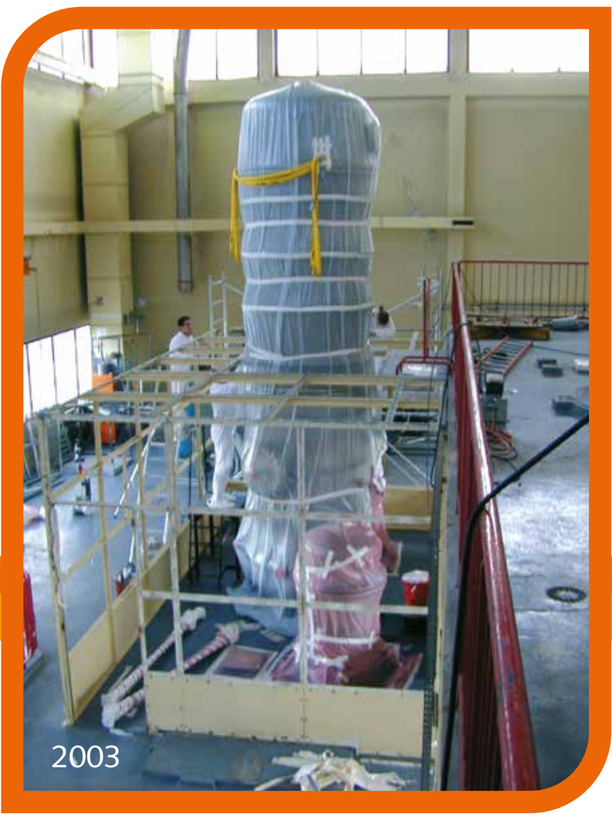
Le procédé en cours de démantèlement (2003).
