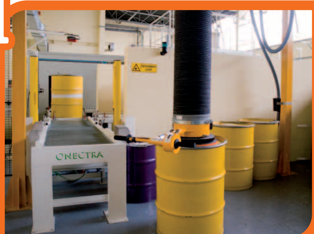
Installation Sandra B à Fontenay-aux-Roses.
