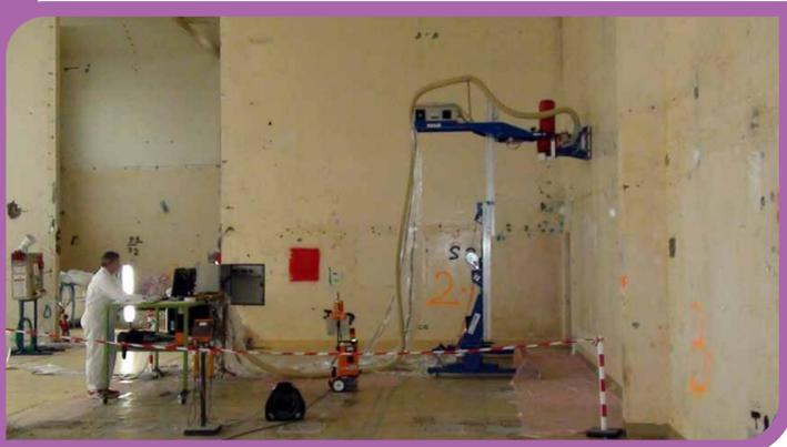
L'AspiLaser®, développé au CEA, pour le décapage par laser des surfaces contaminées.
