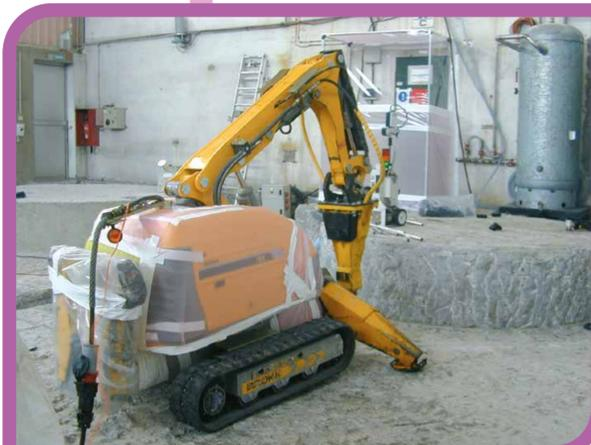
Brokk® utilisé lors de l'assainissement de la salle des cuves de la station de traitement des effluents liquides de Fontenay-aux-Roses.
