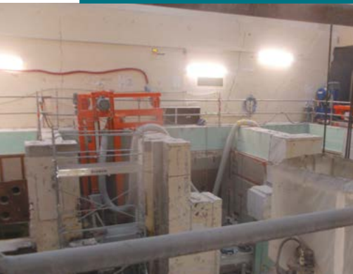
Bâtiment 52-2 démantèlement de la petite ligne.
