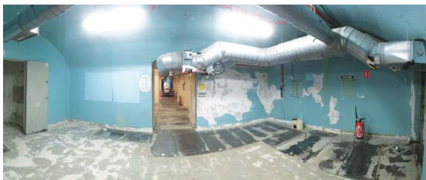
Bâtiment 95, la fin du démantèlement des procédés.
