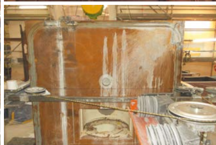
Bâtiment 52-2 découpe d'une porte au câble diamanté.
