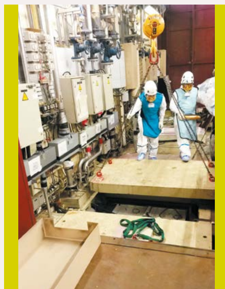
Photos de couverture : Travaux préalables à l'assainissement de la chaîne blindée Prolixe. © CEA
