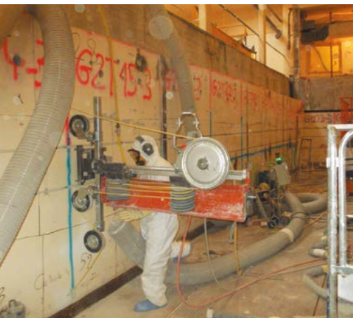
Bâtiment 52-2 découpe d'un voile (mur) en béton.
