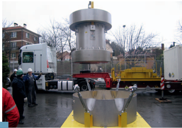
Tests d'utilisation de l'emballage Sorg, qui permettra d'évacuer des effluents de la cuve Circé vers Marcoule.
