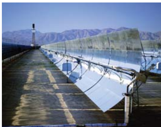
Une des trois installations solaires thermodynamiques à capteurs cylindro-paraboliques construites dans les années 80 par Luz Solar en Californie.
