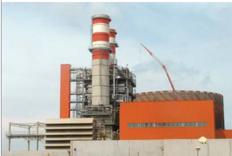
Train 1 de la nouvelle centrale à cycle combiné Dunkerque 6 que Gaz de France doit mettre en service en 2005 à proximité de l'usine sidérurgique d'Arcelor. C'est la première grosse installation à turbine à gaz et cycle combiné construite dans l'Hexagone, avec une capacité de production électrique de deux fois 400 MWe.
