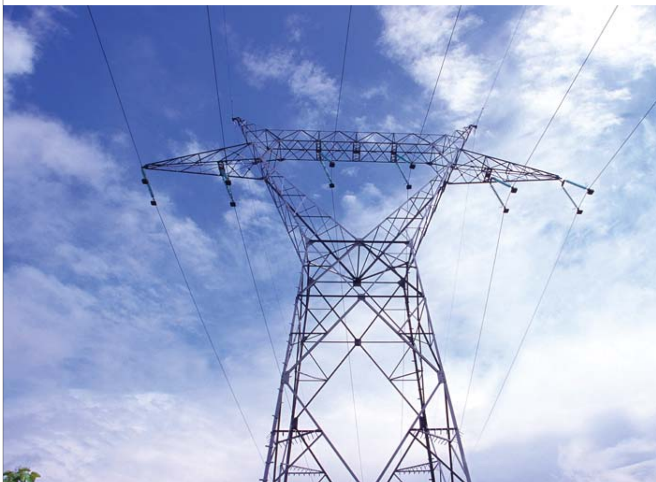
Ligne à haute tension exploitée par RTE. Le marché français est aujourd'hui ouvert à hauteur de 37% pour le gaz et l'électricité, conformément aux objectifs communautaires.
