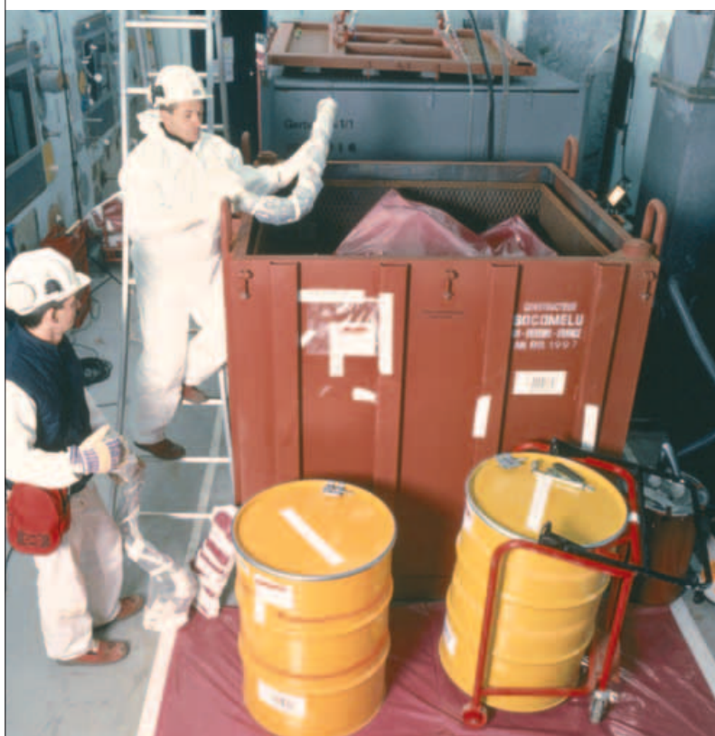
Mise en conteneur de produits de démantèlement de la centrale de Brennilis (Finistère).
