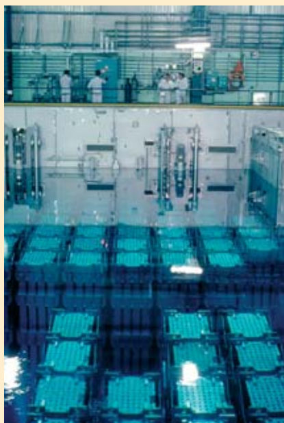
Après déchargement, les combustibles usés sont entreposés dans des piscines de refroidissement pour que leur radioactivité diminue de façon significative. Ici, piscine d'entreposage de l'usine de traitement des combustibles usés d'Areva à La Hague.
