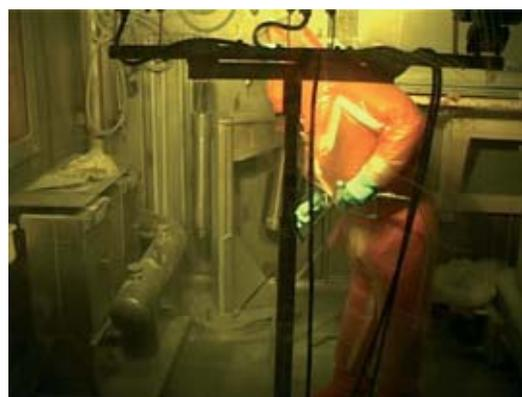
Décontamination par gel aspirable d'une cellule de l'installation ISAI, au centre CEA de Marcoule.
