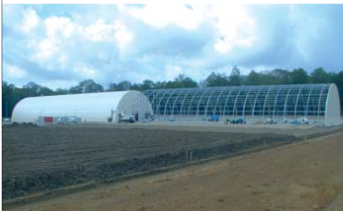
Au Centre de stockage de Morvilliers, les déchets TFA sont mis en place dans les alvéoles, protégés de la pluie par des toits mobiles.
