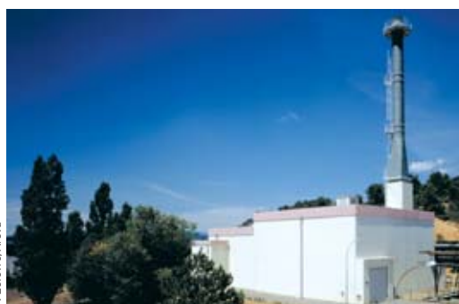
Vue extérieure de l'installation Cascad (CASemate CADarache) au CEA/Cadarache.
