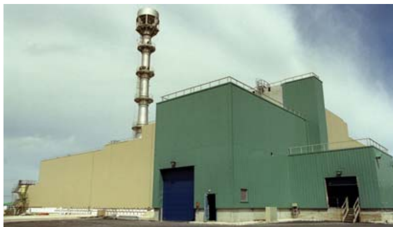
L'entrepôt ECC à La Hague. Sa capacité de 24 000 colis standard de déchets compactés peut être accrue en construisant des modules d'entreposage complémentaires.
