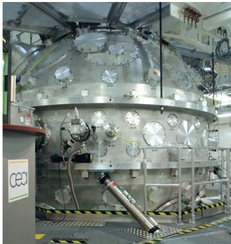
La chambre d’expérience de la LIL en cours d’équipement. Les premières expériences sont prévues pour le courant de 2004.
