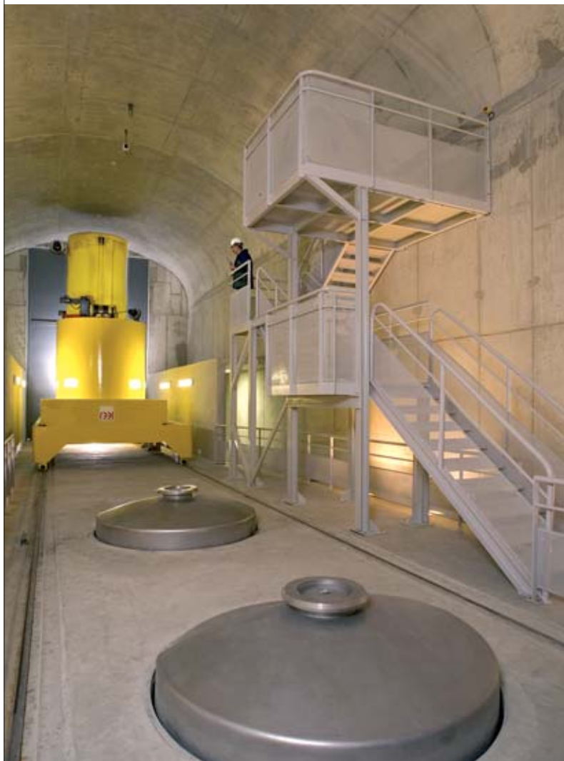
Galerie d'activité de tests pour l'entreposage (Galatée) construite au centre CEA de Marcoule (Gard) pour l'étude de l'entreposage de longue durée de déchets "thermiques". Deux têtes de puits et un "château" de 170 tonnes, pour la manutention des conteneurs, apparaissent respectivement au premier plan et à l'arrière-plan.
