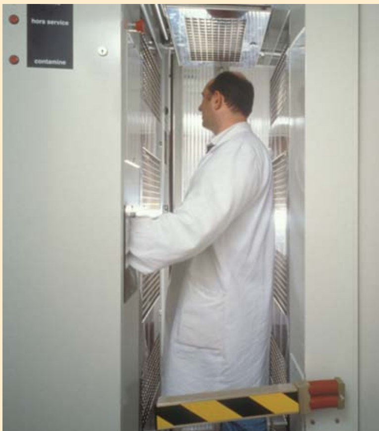
Le passage sous un portique de détection de la contamination des personnes en sortie de zone contrôlée – ici le réacteur Osiris au CEA/Saclay – est une obligation réglementaire.
