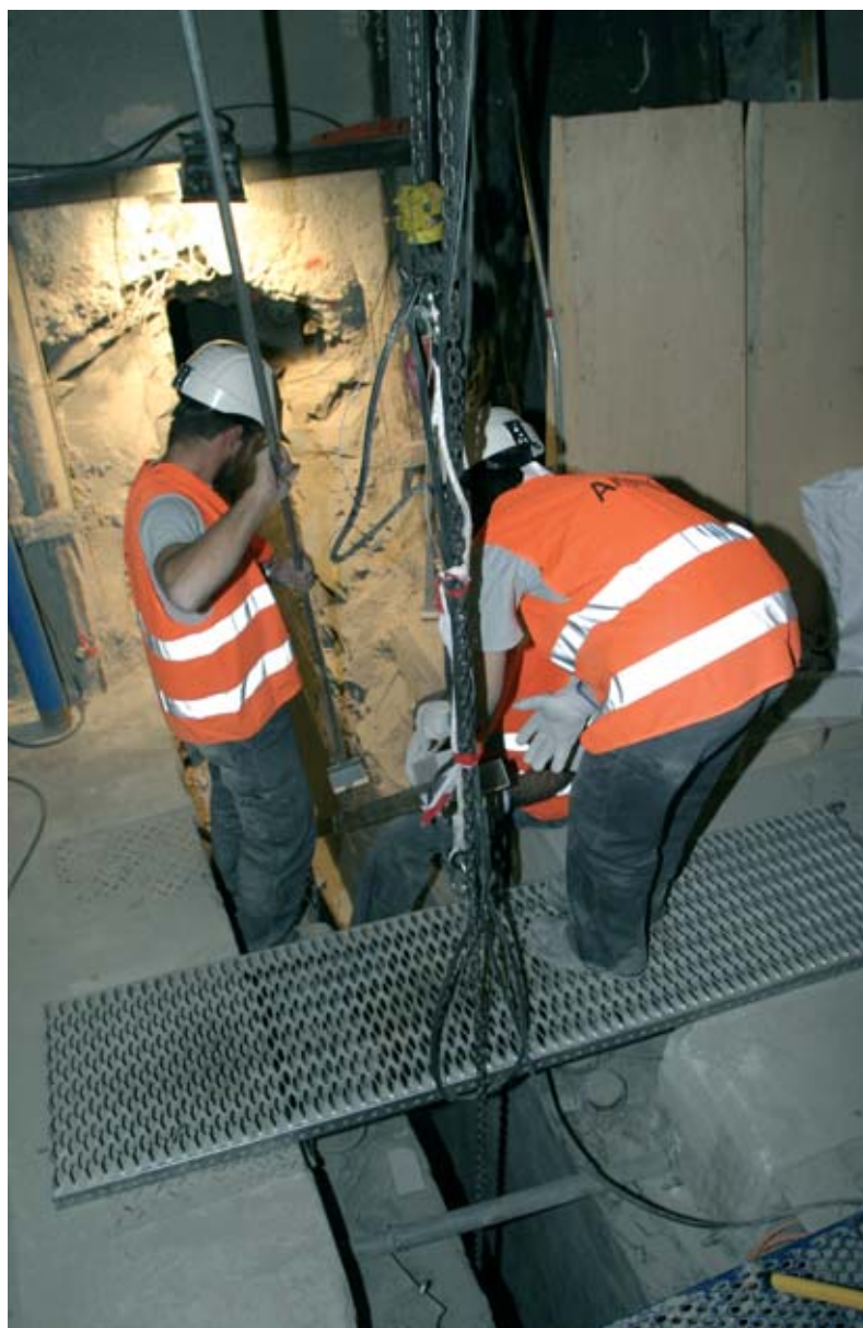
Construit à 500 m de profondeur à la limite de la Meuse et de la Haute-Marne, dans une couche argileuse âgée de 150 millions d'années, le Laboratoire de recherche souterrain de l'Andra est un outil de recherches multidisciplinaires pour étudier les conditions de stockage en milieu géologique profond des déchets radioactifs à vie longue. Ici, expérimentation menée au fond du puits.
