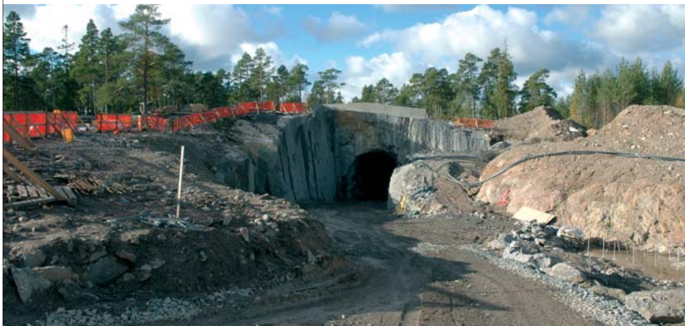
Creusement de galerie sur le site du laboratoire souterrain de caractérisation d'Onkalo (Finlande).
