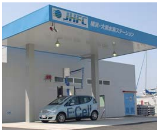
Station hydrogène de Yokohama-Daikoku (alimentée par une unité de reformage à la vapeur) mise en service dans le cadre du projet japonais JHFC (Japan Hydrogen and Fuel Cell demonstration project).
