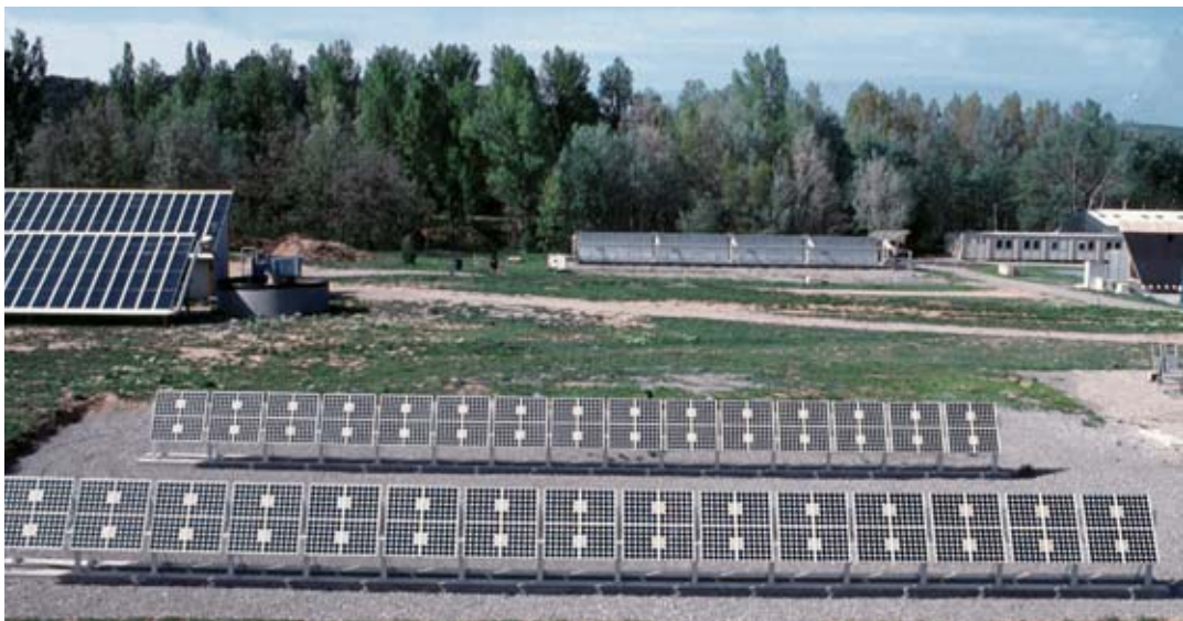
Bancs de caractérisation de modules de la plate-forme SOL.
