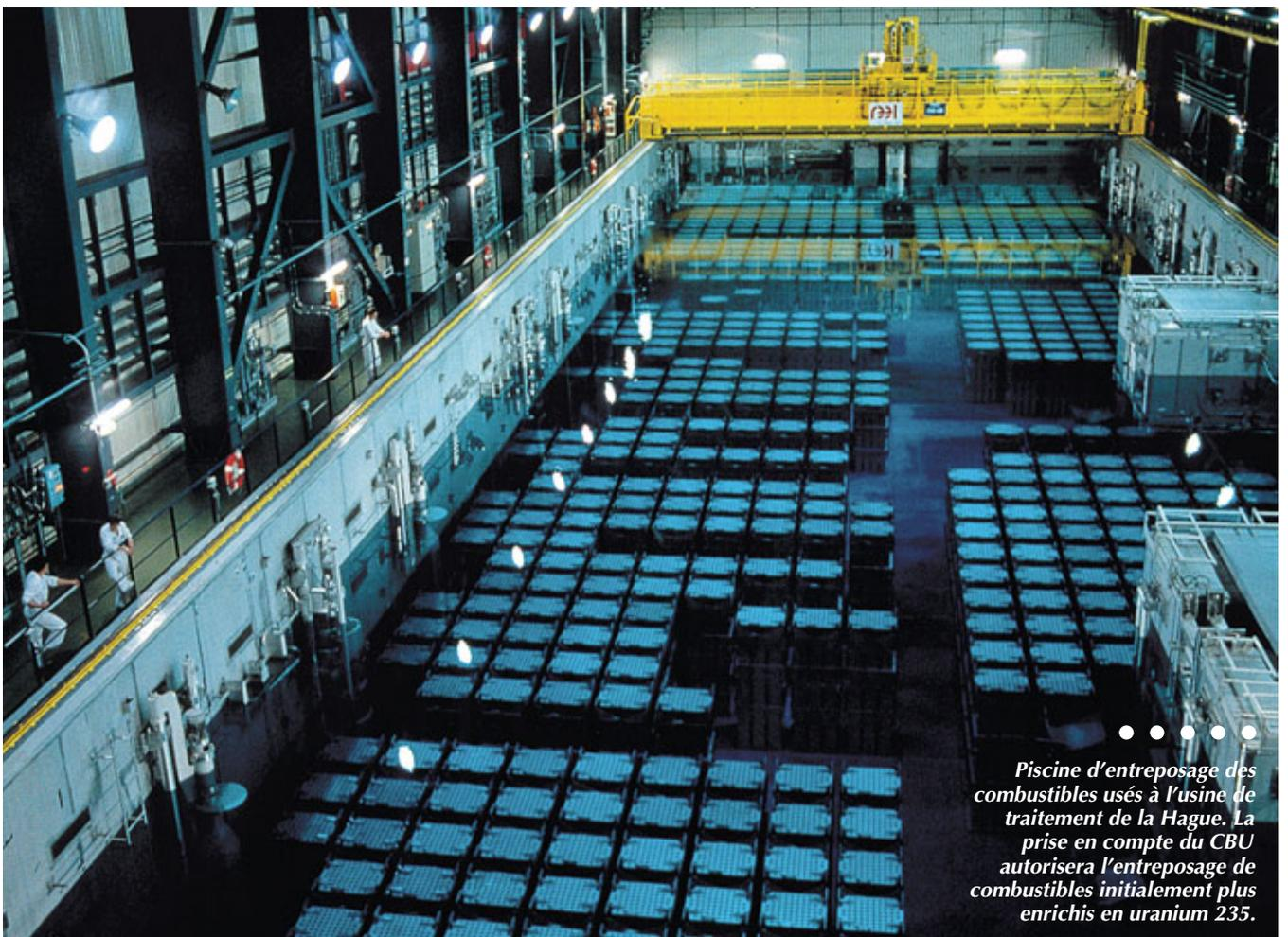
Piscine d'entreposage des combustibles usés à l'usine de traitement de la Hague. La prise en compte du CBU autorisera l'entreposage de combustibles initialement plus enrichis en uranium 235.
