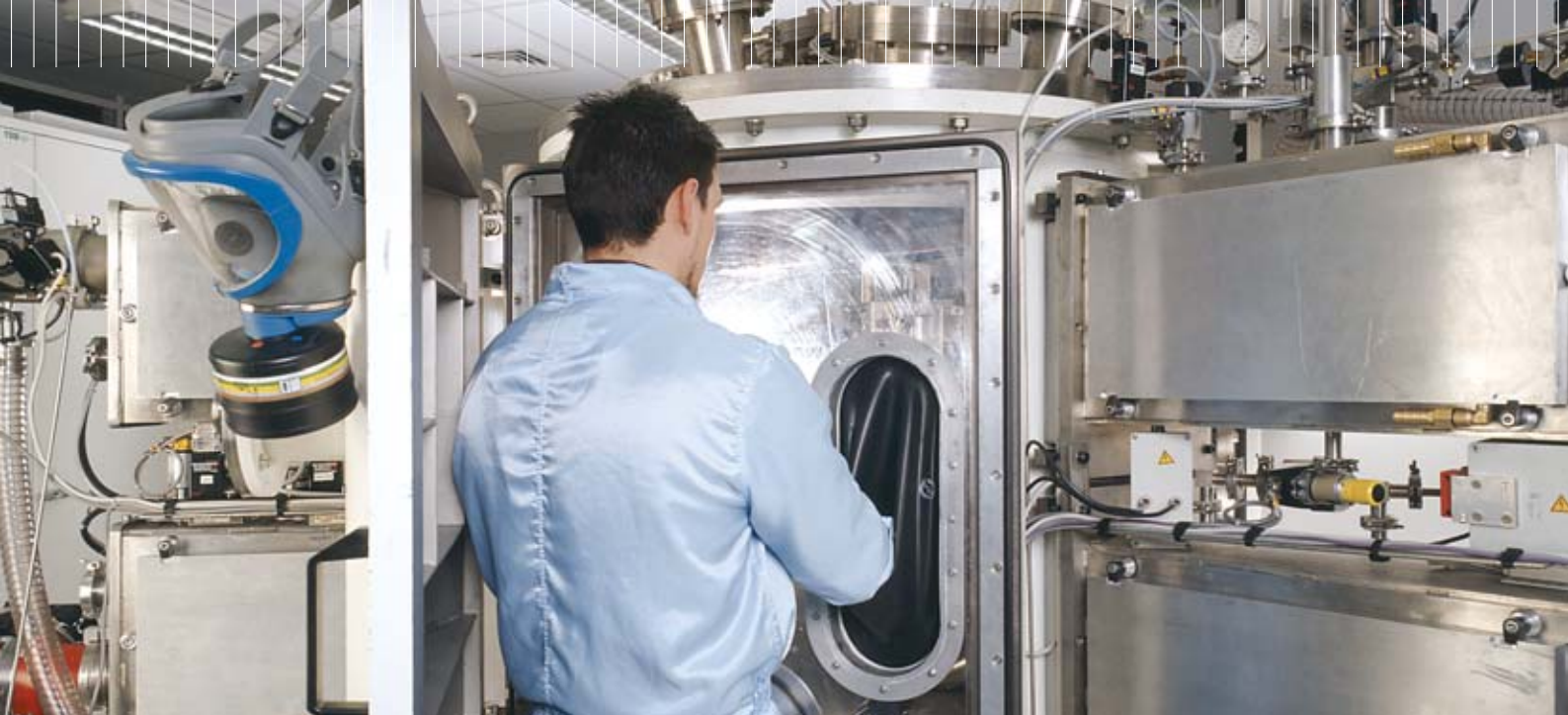
Installation de fabrication de batteries lithium en couches minces dans l'enceinte du laboratoire commun CEA-HEF au CEA/Grenoble. Ces microbatteries sont notamment utilisables pour la sécurisation de cartes à puce.
