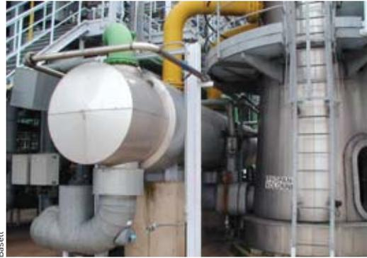
Échangeur thermique à tubes horizontaux à hautes performances installé sur le site de production de polypropylène de Knapsack en Allemagne. L'échangeur est placé au pied d'une colonne de distillation pour la purification du propylène, et le bas de la colonne est chargé en **propane** qui est vaporisé dans l'échangeur.
