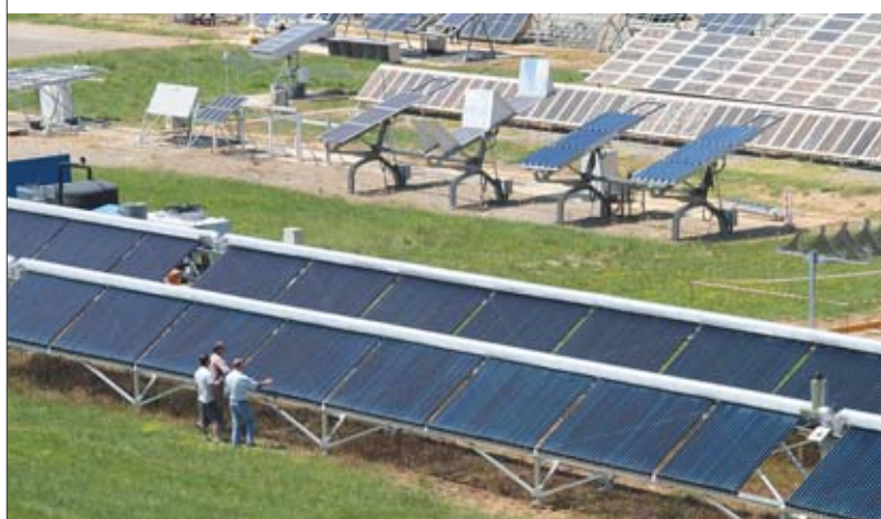
Boucles de capteurs solaires thermiques du démonstrateur SAED installé sur la plateforme solaire du CEA à Cadarache. Les boucles, mesurant environ 200 m et montées en parallèle, sont composées de tuyauteries entièrement soudées en acier noir.
