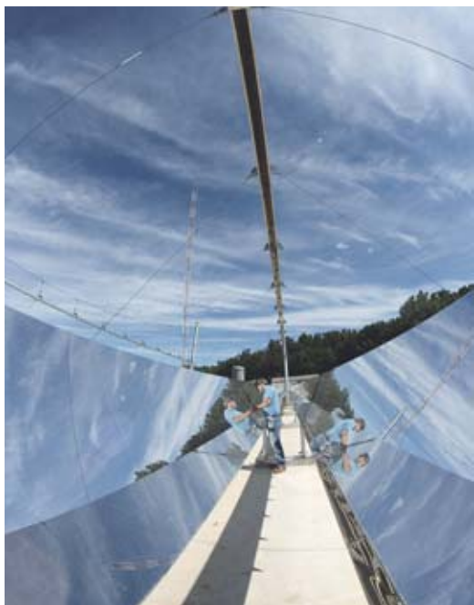
Au cœur des miroirs de Fresnel du prototype ALSOLEN. Au lieu de courber les miroirs, processus coûteux, les miroirs de Fresnel sont très légèrement incurvés.
