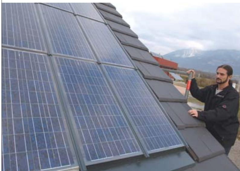
Capteurs solaires photovoltaïques intégrés en toiture (Ines).
