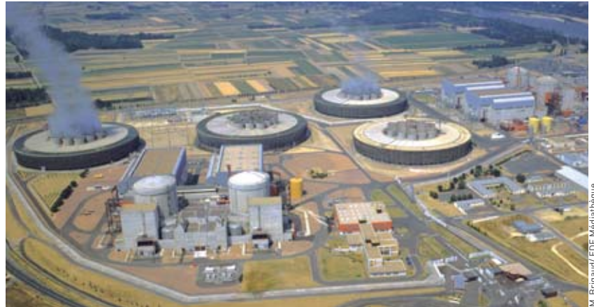
Les quatre tranches REP de la centrale EDF d'Avoine, près de Chinon, appartiennent à la deuxième génération de réacteurs nucléaires.
