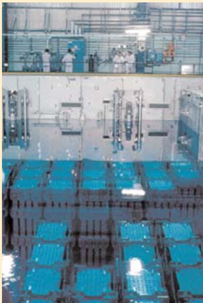
Après déchargement, les combustibles usés sont entreposés dans des piscines de refroidissement pour que leur radioactivité diminue de façon significative. Ici, piscine d'entreposage de l'usine de traitement des combustibles usés d'Areva à La Hague.
