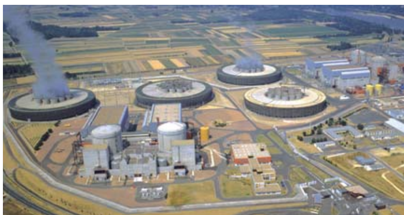
Les quatre tranches REP de la centrale EDF d'Avoine, près de Chinon, appartiennent à la deuxième génération de réacteurs nucléaires.
