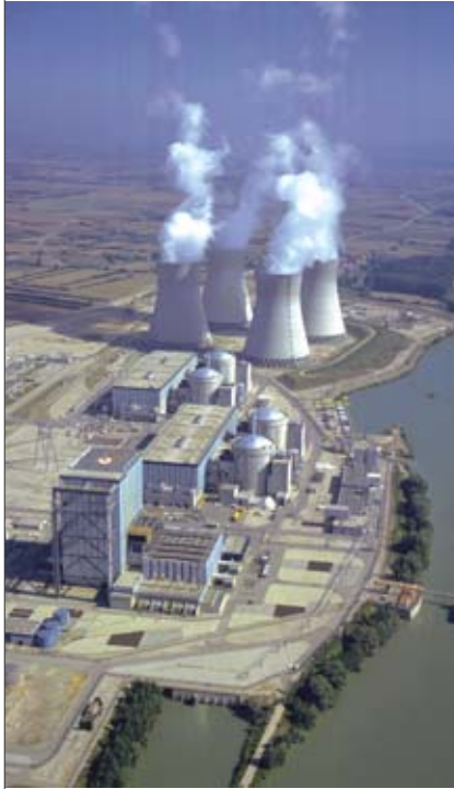
Le site EDF du Bugey (Ain) compte à la fois le dernier représentant de la filière UNGG, de première génération (au premier plan), et quatre réacteurs REP de la deuxième génération (au second plan).
