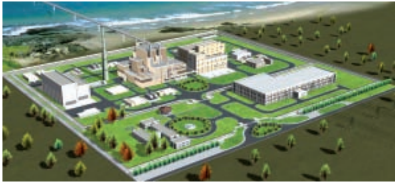
Vue d'architecte du PFBR (Prototype Fast Breeder Reactor), d'une puissance de 500 MWe, en construction en Inde.
