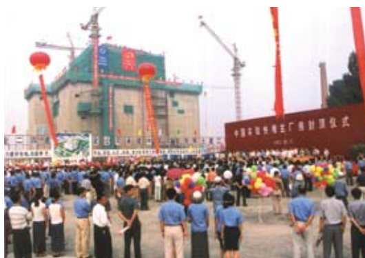
Le réacteur à neutrons rapides à caloporteur sodium chinois CEFR ( China Experimental Fast Reactor ) en cours de construction. Ce réacteur expérimental sera de type intégré, comportera deux boucles sodium secondaires et aura pour combustible un oxyde mixte d'uranium et de plutonium. Il délivrera une puissance de 25 MWe. Sa divergence est prévue pour 2009.
