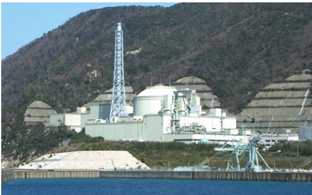
Le réacteur expérimental à neutrons rapides refroidi au sodium Monju, au Japon. Arrêté actuellement pour modifications, il doit entrer à nouveau en service en 2009. Il est prévu d'irradier dans ce réacteur un assemblage combustible chargé en actinides mineurs en 2020, dans le cadre du programme GACID.
