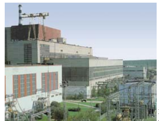
Le réacteur à neutrons rapides à caloporteur sodium BN-600, situé à Beloyarsk en Russie, délivre une puissance de 600 MWe.
