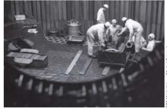
Montage des empilements de graphite du réacteur EDF3 de Chinon, au milieu des années soixante.
