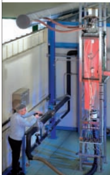
Installation Esthair (Essais thermoaérodynamiques en air), au centre CEA de Grenoble, destinée notamment à évaluer les coefficients de frottement et d'échange de chaleur pour l'élément combustible de type "aiguilles" du cœur de démarrage du REDT.
