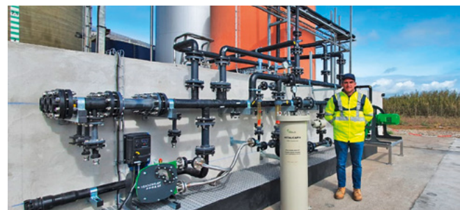
↑ Figure 5 : Installation industrielle de traitement d'effluents liquides industriels et une colonne M7 garnie de fibres AJELIS sur le site de Paimboeuf de la société ARETZIA du groupe CHIMIREC.
