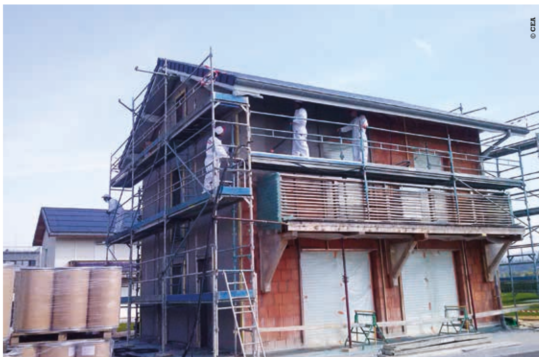
Application, sur une maison Incas, de l'enduit super-isolant à base d'aérogel développé par le CEA et des partenaires industriels.
