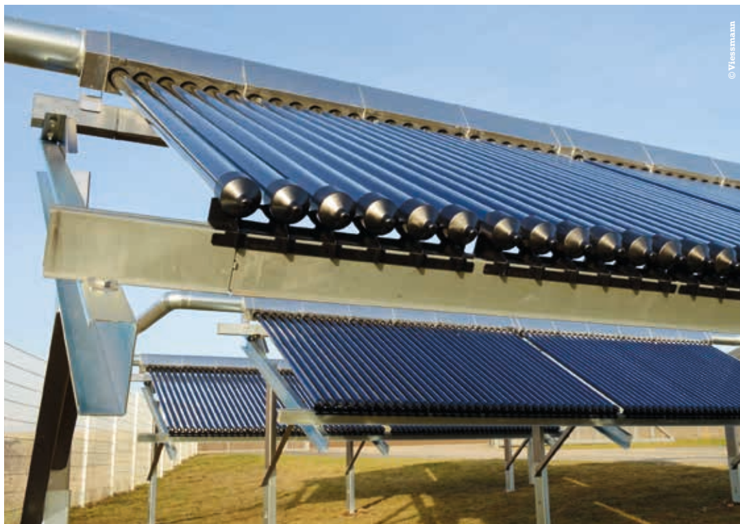
◀ Capteurs solaires à tubes sous vide, développés par le CEA-Liten et la société Viessmann.
