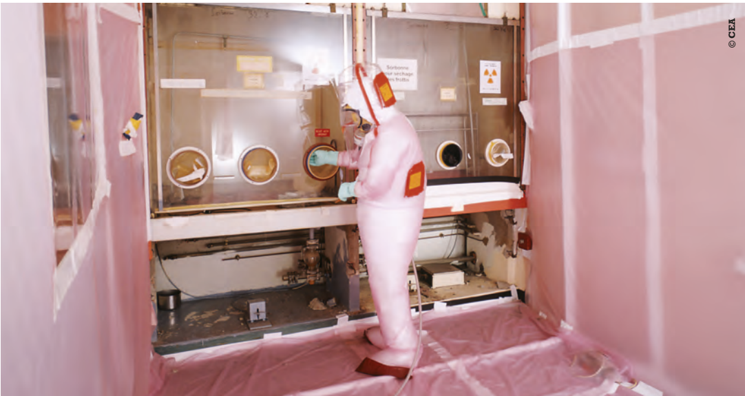
◀ Chantier d'assainissement d'une sorbonne ventilée de type boîte à gants à Fontenay-aux-Roses.
