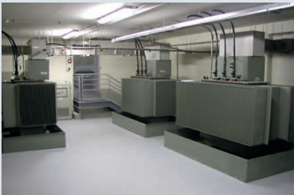
Les postes haute-tension transformant le courant « secteur » en courant utilisable par la machine.
