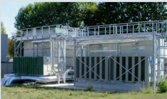
Tours aéroréfrigérantes servant à évacuer la chaleur du calculateur. Plusieurs équipements de ce type sont indispensables pour évacuer plusieurs mégawatts.
