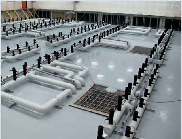
Arrivées d'eau servant au refroidissement des nœuds de calcul, ici dans une salle machine en cours de réalisation. Le plancher final sera à la hauteur de séparation entre partie noire et partie blanche du mur du fond.
