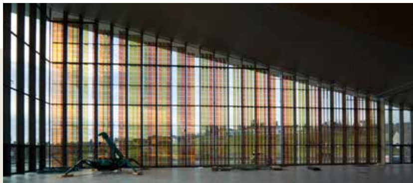
Les panneaux photovoltaïques réalisés avec les colorants sans ruthénium élaborés à l'Inac recouvrent la façade du bâtiment de conférence de l'EPFL, à Lausanne. Une première !
