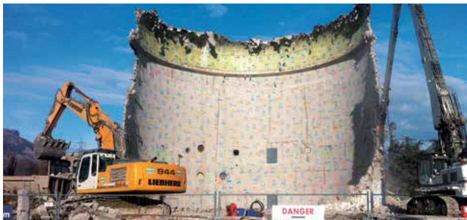
Démolition du bâtiment réacteur de Siloé à Grenoble.
